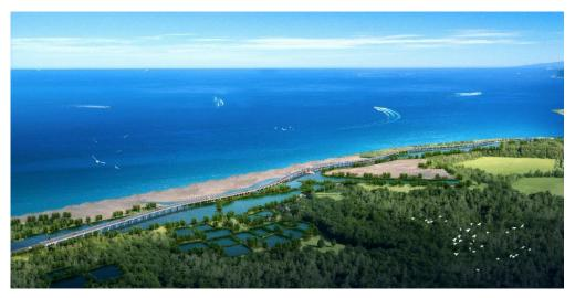
三家昌化江大桥: 位于昌江县境内,桥梁全长 1357. 2m, 宽 18m, 桥梁连接 东方市三家镇及昌江县昌化镇,主桥上跨昌化江,将两岸民众通行的时间缩短了一个小时。桥梁上部结构形式为斜腹板变截面连续梁桥,主跨为 3 跨 90m 跨径。下部结构借鉴木棉花的意向进行设计,主桥采用独柱花瓶墩,引桥采用双柱花瓶墩。桥梁的护栏采用防撞护栏+大理石景观栏杆的形式,大理石栏杆上雕刻有木棉花的浮雕,旅游气息浓厚。
