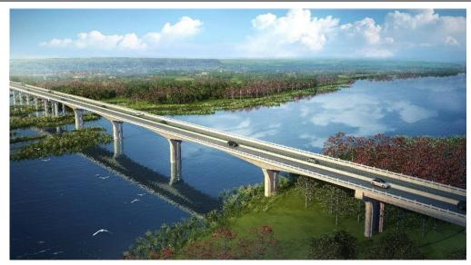
珠碧江特大桥:珠碧江特大桥连接昌江县海尾镇与儋州市海头镇,桥梁全长3072.2m。引桥以全高架桥方案跨越海尾镇、海头镇滩地,全宽18.0m;主桥跨越昌江县和儋州市界河——珠碧江,全宽25.0m,采用50+90+90+90+50=370m跨径拱形斜腿钢构形式。主桥桥型从飞翔的白鹭中抽取造型元素,桥墩采用造型立体感较强,且呼应白鹭身体形态的墩型,以形成较为完整的"一行白鹭上青天"之造型形态,桥型结构能较好的融入周边优美的自然风光。护栏采用防撞护栏+大理石景观栏杆,制造浓厚的旅游氛围。
